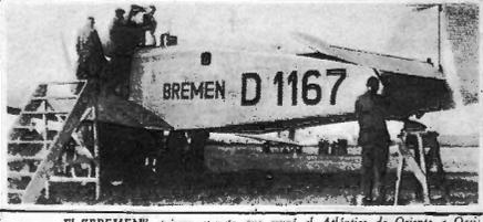
El "BREMEN", primer aparato que cruzó el Atlántico de Oriente a Occidente. Es un "Junkers" monomotor, construido enteramente de metal. Este tipo de aeroplano, desarrollado en Alemania después de la guerra, se distingue por el fuselaje y el motor, que descansan directamente sobre las alas.
