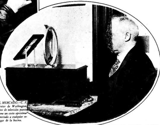
**LA TELEVISION EN EL MERCADO**—C. F. JENKINS, conocido inventor de Washington, examinando el primer receptor de televisión puesto al mercado. Este aparato tiene un costo aproximado de \$150, y puede ser conectado a cualquier receptor corriente, en lugar de la bocina.
